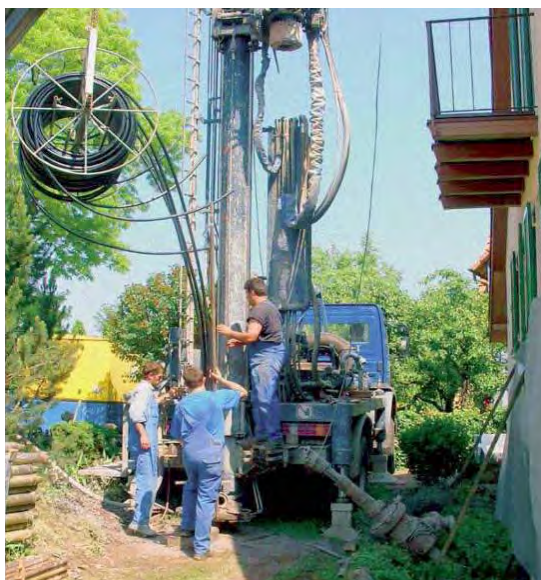
Einbau einer Doppel-U Sonde in die abgeteufte Bohrung.
