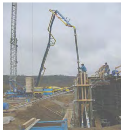
Herstellung der Widerlager für Bauwerk 6 bei Wackershofen
