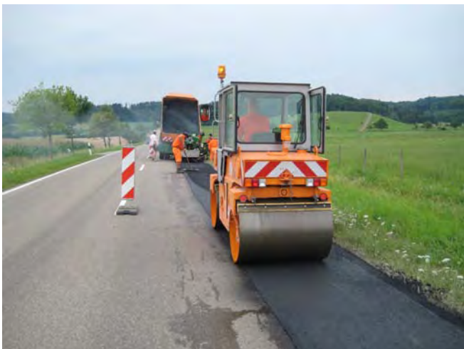
Partielle Fahrbahndeckensanierung
