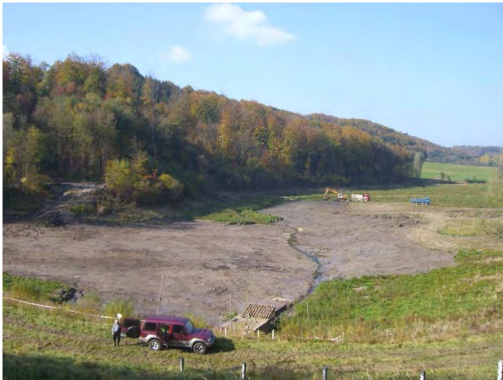
Entlandung des Hochwasserrückhaltebeckens Gnadental
