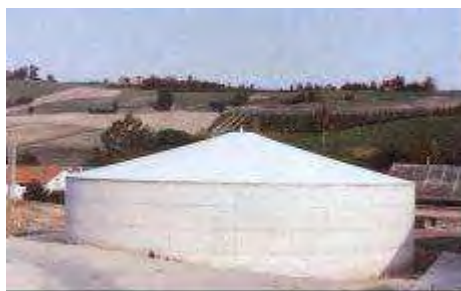
Güllelager mit Abdeckung
