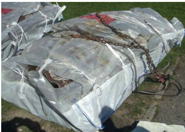
Unsachgemäße Lagerung von Wellasbestzementplatten bei Gebäudesanierung
