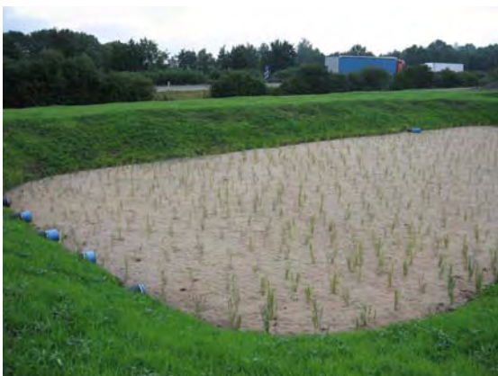
Retentionbodenfilter mit noch jungem Binsenbewuchs zur Entwässerung eines Gewerbegebiets im Landkreis
