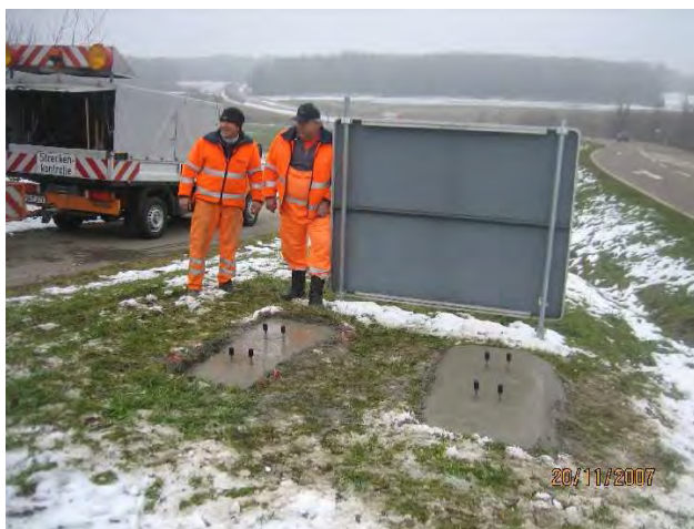
Montage eines Verkehrszeichens
