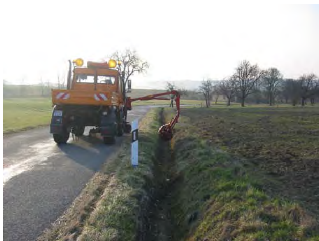
Reinigung einer Entwässerungsmulde
