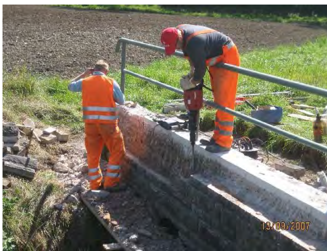
Instandsetzung einer Brücke
