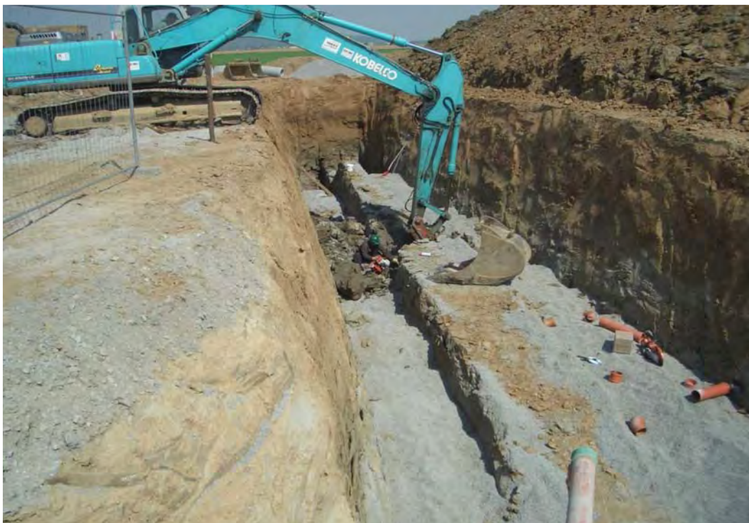
Gefährdung von Beschäftigten bei Erdarbeiten
