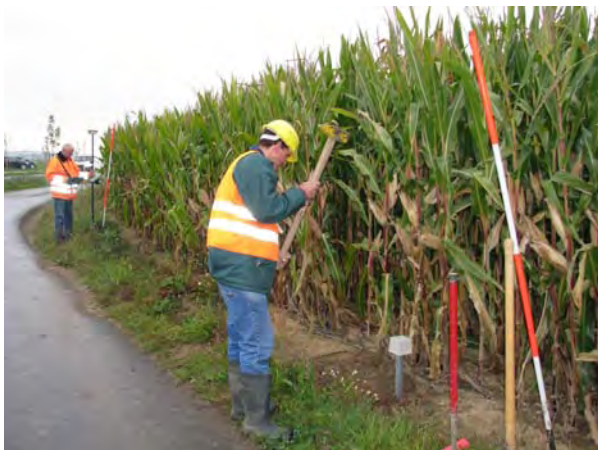
Abmarkungsarbeiten mit GPS an der Schwäbisch Haller Ostumgehung
