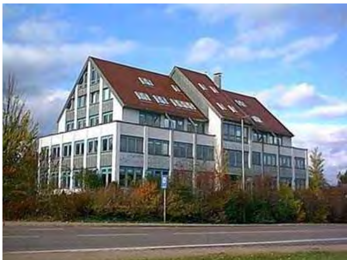
Vermessungsamt – Dienstgebäude Schwäbisch Hall, Gaildorfer Straße 12
