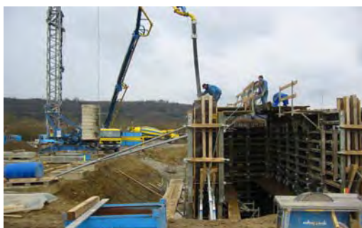
Herstellung der Widerlager für Bauwerk 6 bei Wackershofen
